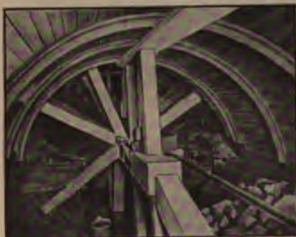
Fig. 184. Attaque à section complète.
